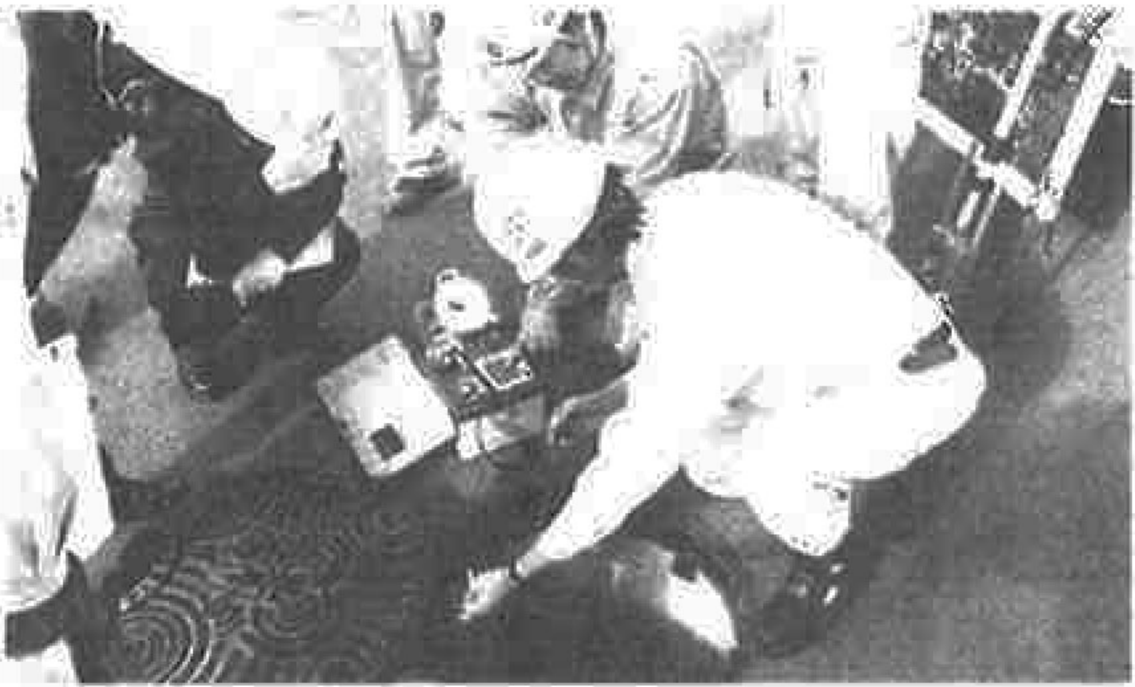
マンホール内酸素濃度の測定作業を実体験
